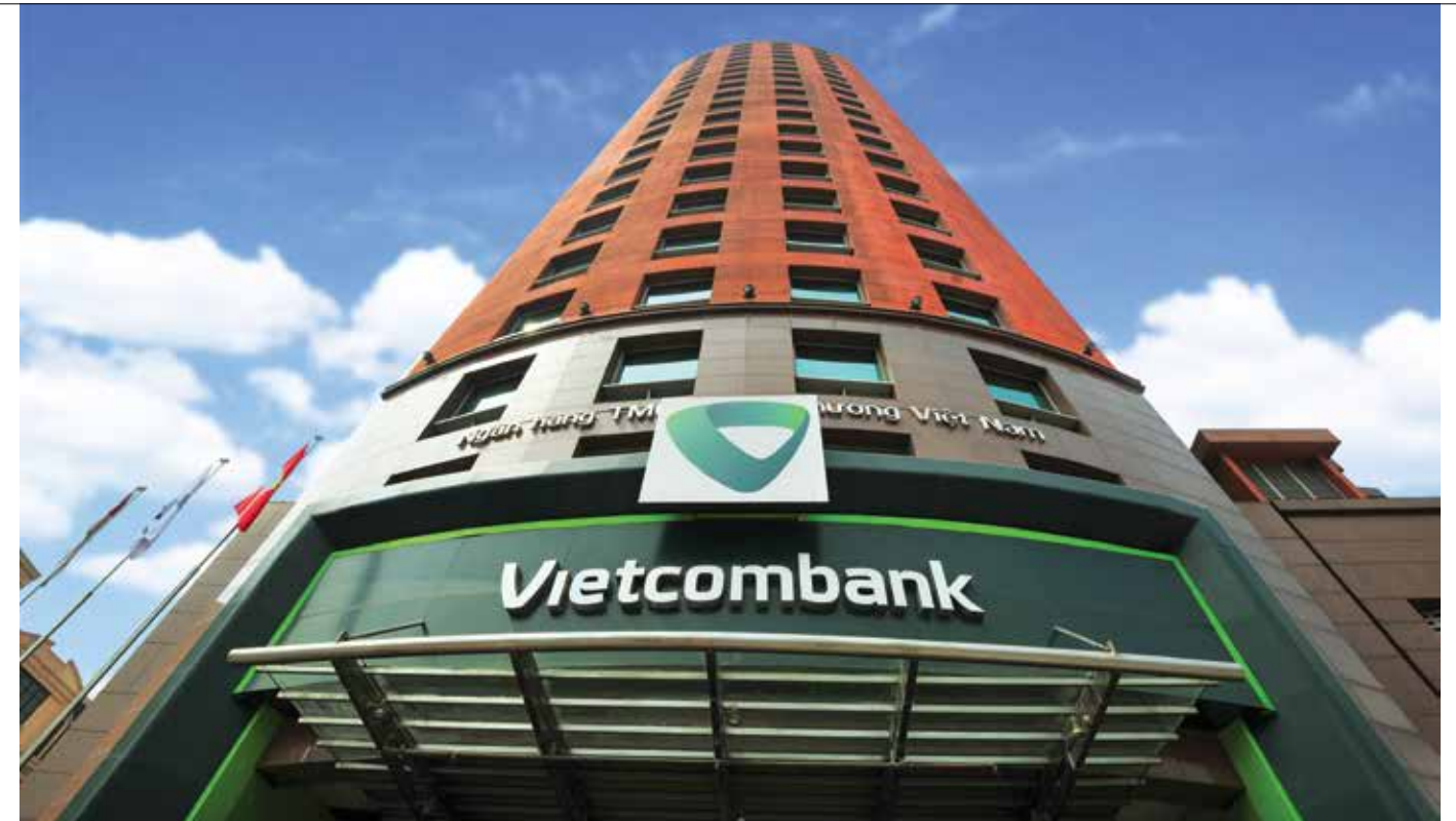
Tòa nhà Trụ sở chính Vietcombank tại địa chỉ số 198 đường Trần Quang Khải, quận Hoàn Kiếm, thành phố Hà Nội, Việt Nam
